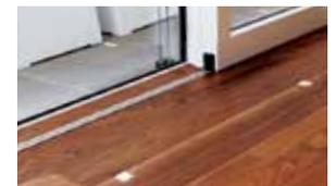
Laufschiene dezent im Fußboden eingelegt.
